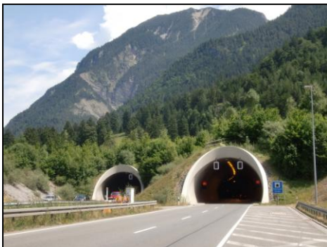
Tunnel Farchant, Garmisch
