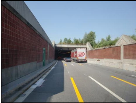
Tunnel Allach bei München
